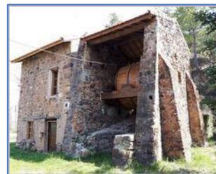
\*\* "La Bobine" (restaurée; entre les points 6 et 7) - elle faisait partie d'un système de transport qui transportait le minerai des mines jusqu'à une ligne de chemin de fer dans la vallée située plus bas.
